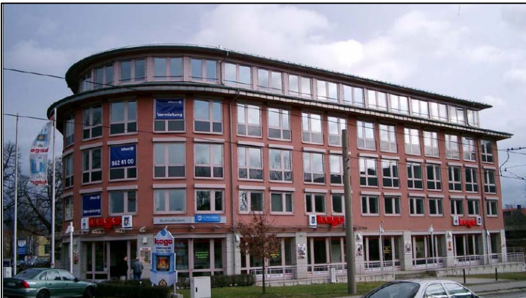
Büro- u. Geschäftshaus, Dresden
