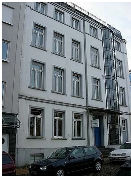
Bürogebäude mit Wohnungen, Schwerin
